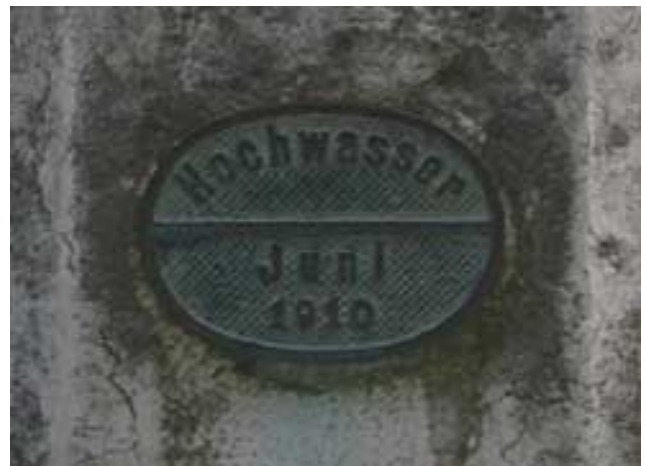
Fig. 5-40: Hochwassermarken am Vierwaldstättersee (LU).
