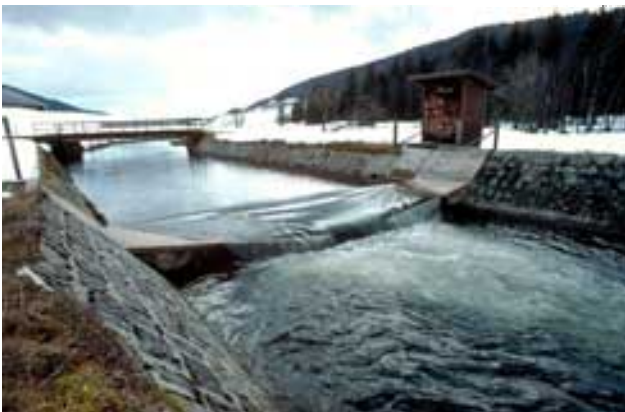
Fig. 5-14: Messstation Orbe – Le Chenit (VD) Messung Wasserstand Schwimmer Messung Abfluss Flügel (mit Niedrigwassergerinne)
