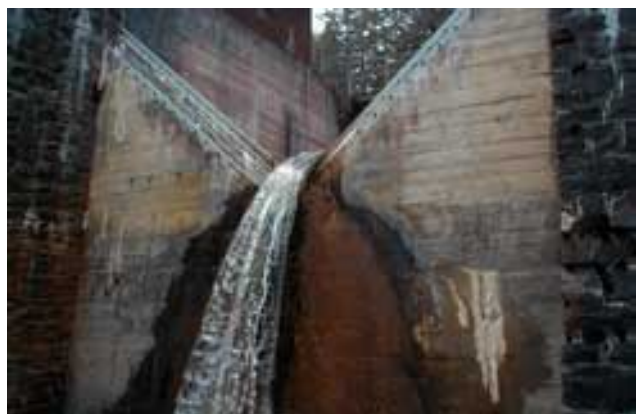
Fig. 5-18: Messstation Rotenbach – Plaffeien (FR) Messung Wasserstand Schwimmer Messung Abfluss Dreiecküberfall, volumetrisch
