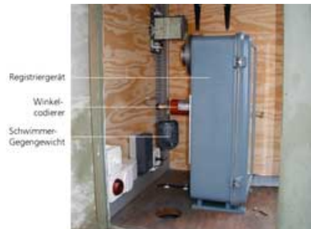
Fig. 5-6: Pegel mit Schwimmerregistriergerät, Inn – St. Moritz Bad (GR).
