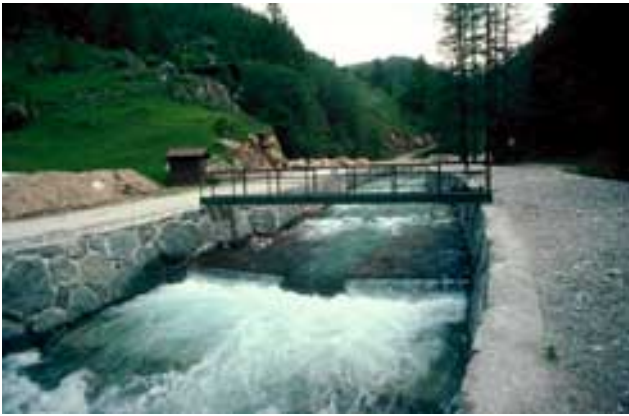
Fig. 5-13: Messstation Goneri – Oberwald (VS) Messung Wasserstand Radar Messung Abfluss Flügel (mit Niedrigwassergerinne)
