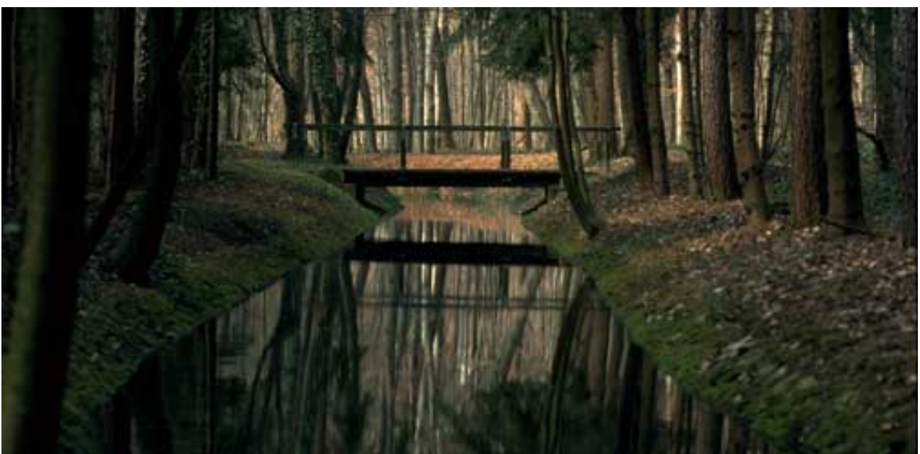
Fig. 7-41: Sickerkanal der Grundwasser-Anreicherungsanlage in der Hard (BL).
