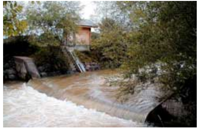
Fig. 5-16: Messstation Gürbe – Burgistein (BE) Messung Wasserstand Pneumatische Pegelmessung Messung Abfluss Flügel
