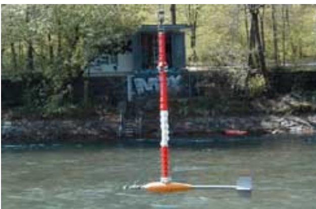
Fig. 5-15: Messstation Aare – Bern (BE) Messung Wasserstand Pneumatische Pegelmessung Messung Abfluss Flügel an Seiflügelanlage
